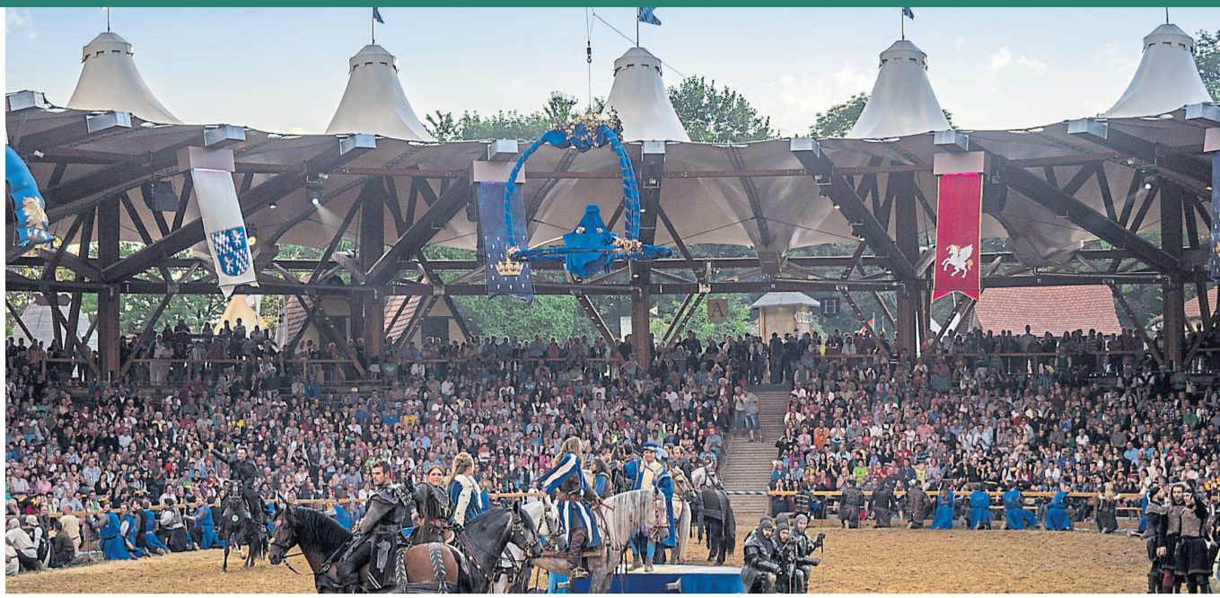
Überdachung der Westtribüne der Kaltenberger Ritterspiele
